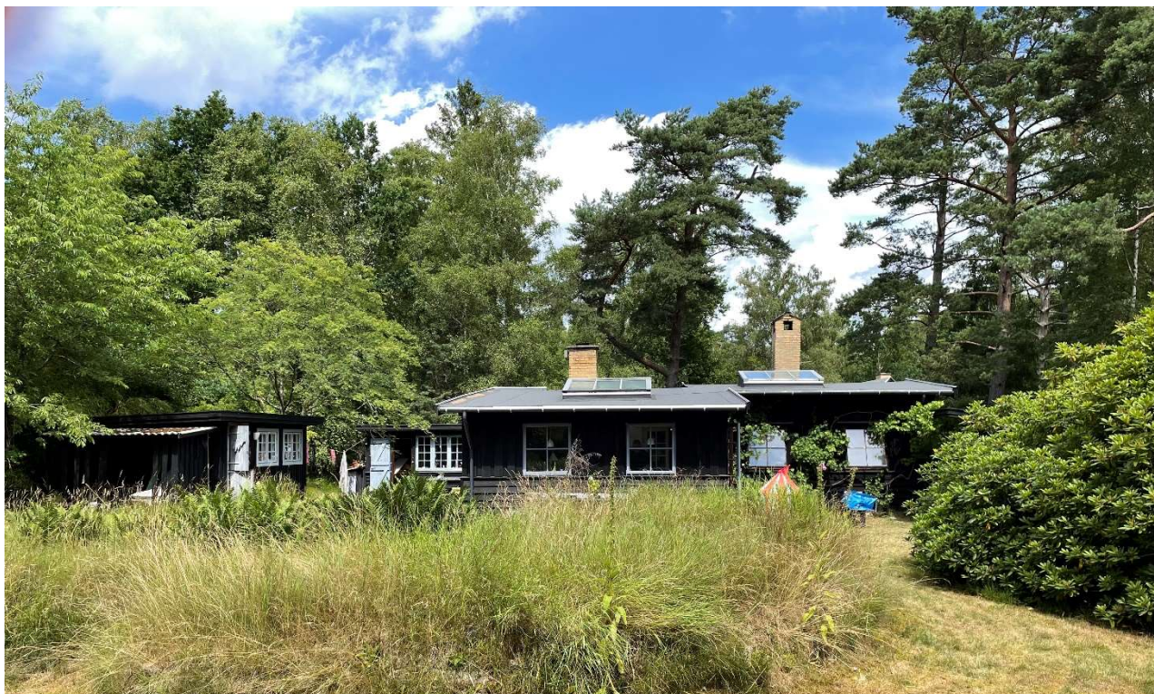
De to nye tage set fra haven.
