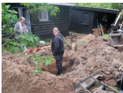
Der lægges ny kloak og nye vandledninger.
